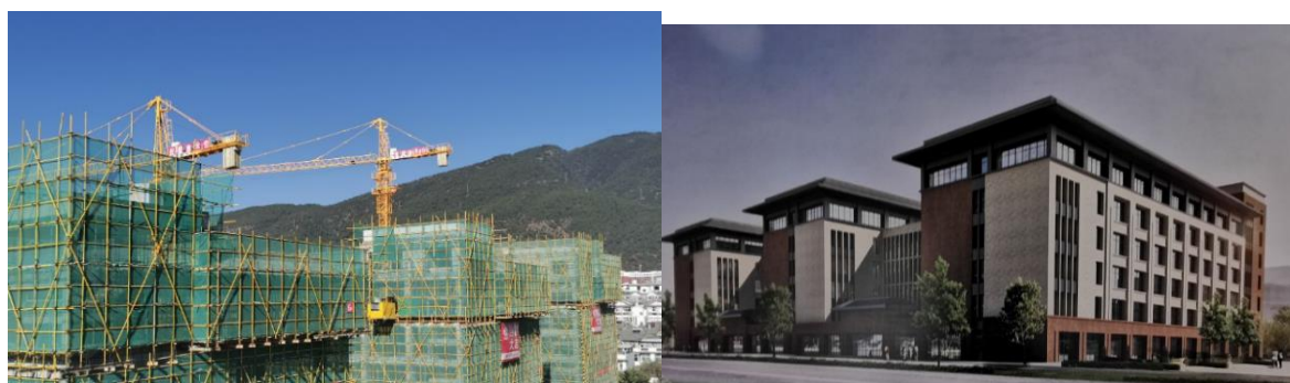
图 26 实验实训中心：施工及效果图
